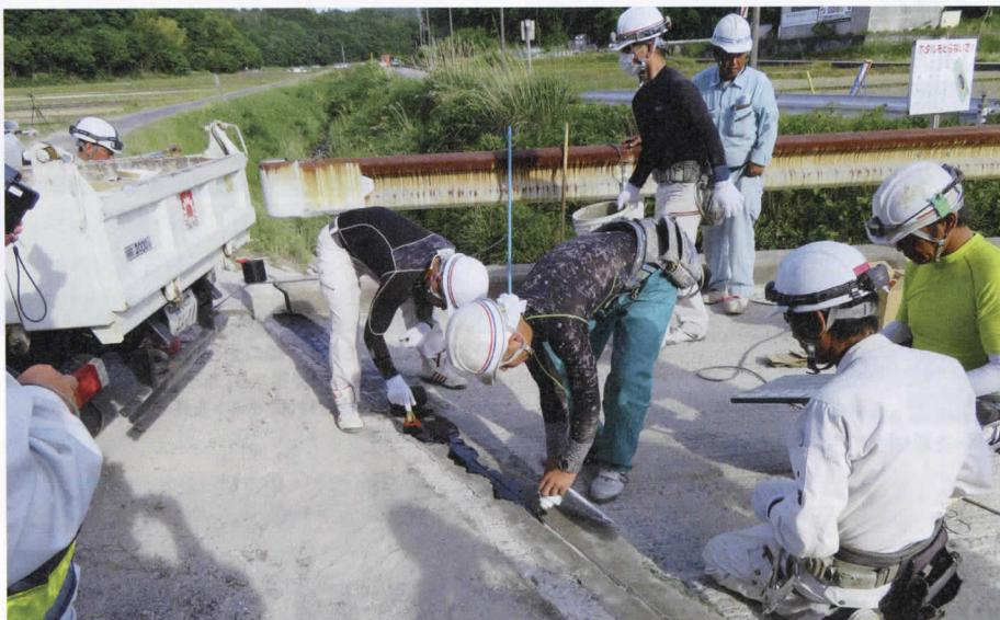
写真3 ■ 黒く見えるのはアスファルト乳剤系の伸縮材。適用できる充填幅は10~20mm、充填深さは20mm
