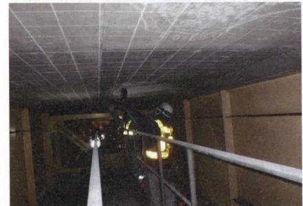
事前調査で鉄筋の位置をマーキング。鉄筋腐食の懸念が大きい範囲は密になるように陽極材の配置を決める
