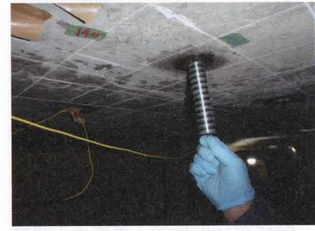
陽極材を挿入。腐食防止と伝導性向上のため周囲にパックフィル材を注入する
