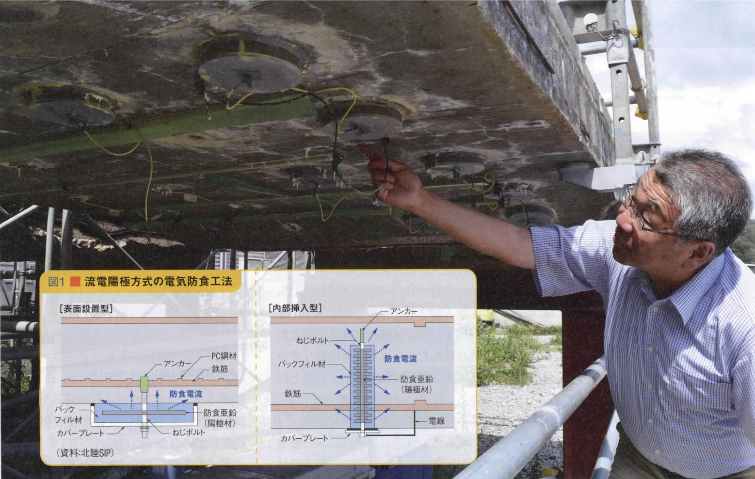
図1 ■ 流電陽極方式の電気防食工法
