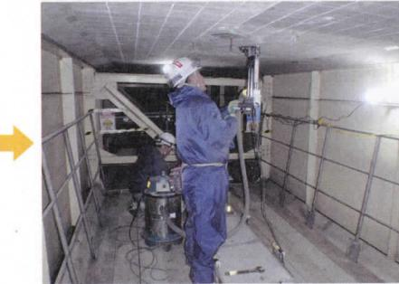
直径4cmのコアを削孔。陽極材を固定するためのアンカーを設置する
