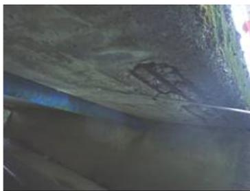
Рис. 4. Короткопролетные мосты с обрушением бетона пролетного строения из-за изначального дефекта
