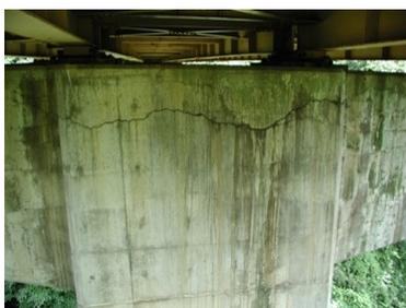
Рис. 6 Пример моста, поврежденного ASR
