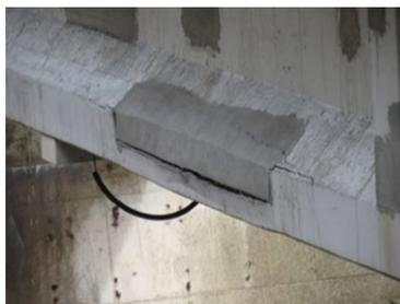
Рис. 7 Пример повторного износа из-за коррозии макроэлементов после ремонта заплатами
