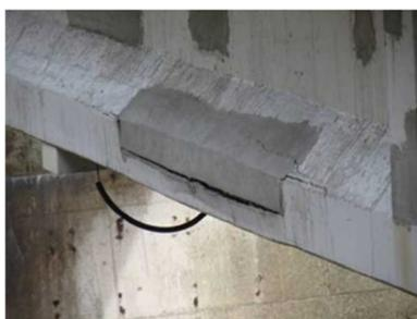
解図 2.5 マクロセル腐食により再劣化した断面修復部の例
