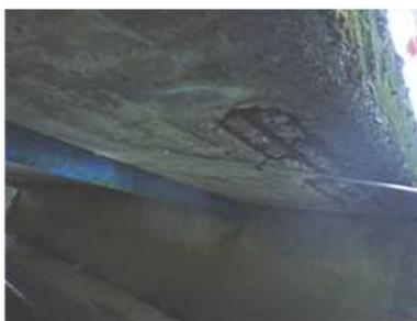
解図 2.2 初期不具合により上部工コンクリートが剥落した短支間橋梁
