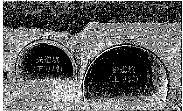
図-14 超近接双設トンネルの鳥浜トンネル
