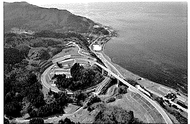
写真-1 鳥川大橋とループ構造
