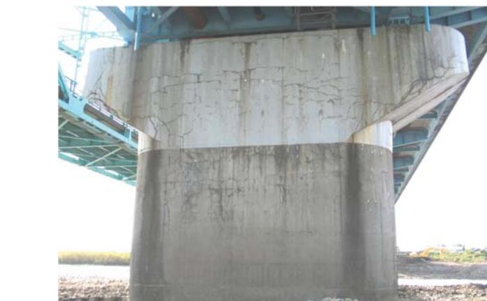
深刻な鉄筋破断による損傷が発生したRC橋脚の打替え
