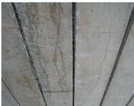
橋軸方向のひび割れ
