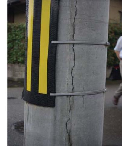
PCa電柱のASRによるひび割れ(FAコンクリートの標準化(H28))<sup>10</sup>
