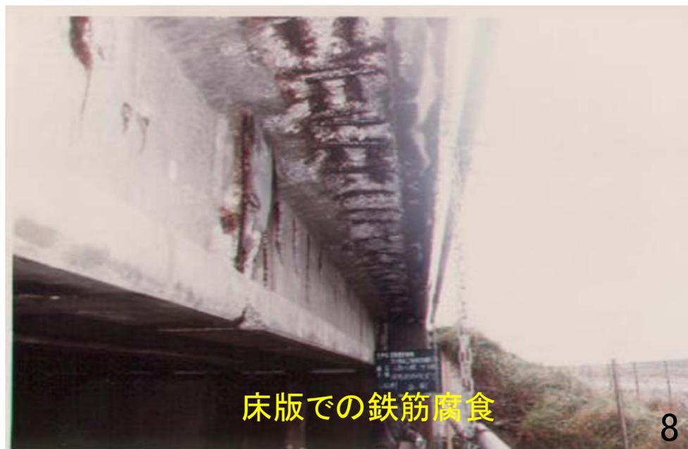
床版での鉄筋腐食
