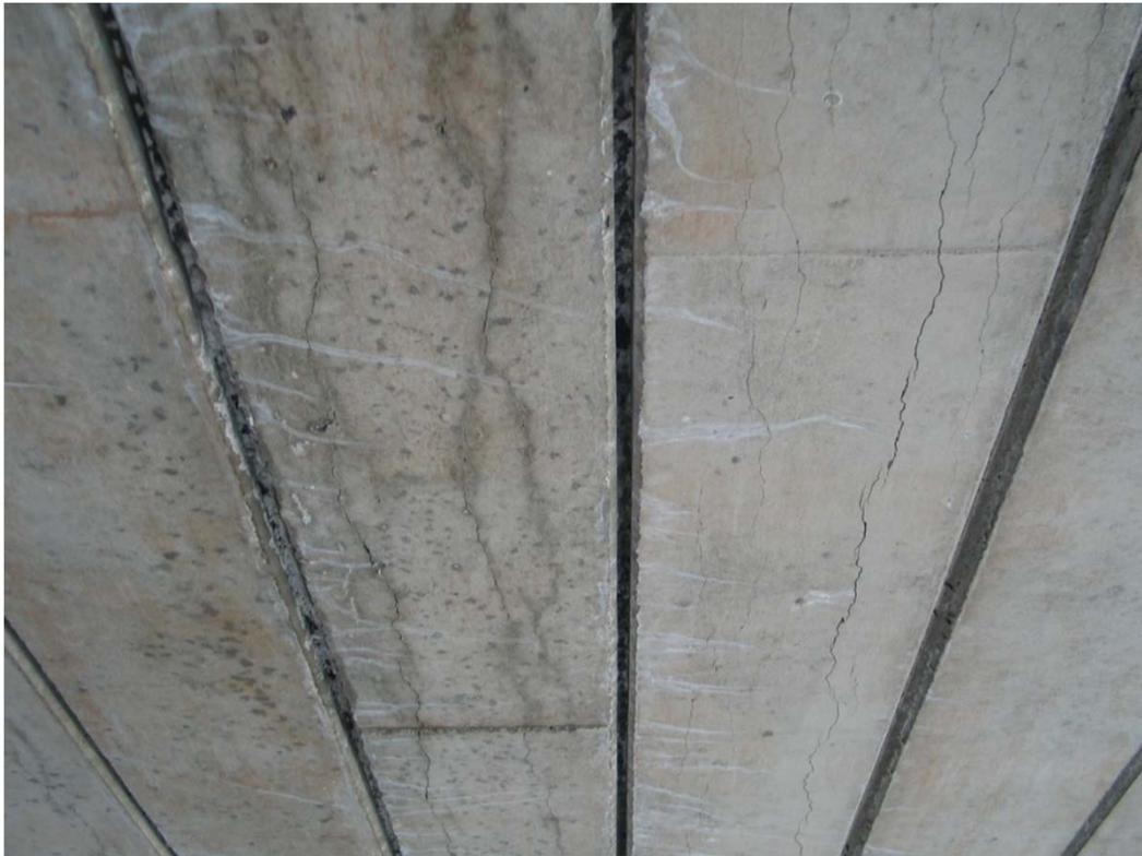
橋軸方向のひび割れ
