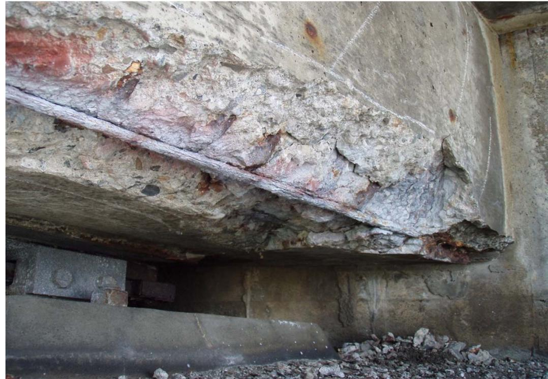
床版端部でのコンクリートの浮きと鉄筋腐食
