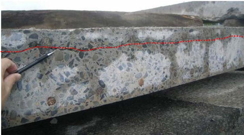
劣化したコンクリート床版の水平ひび割れ
