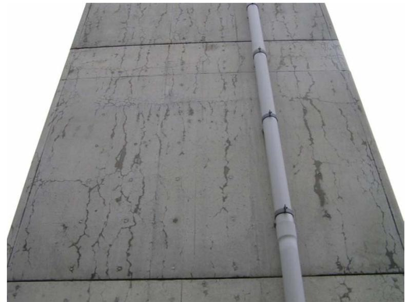
骨材の岩石・鉱物学的特徴, ASR劣化度と部材の使用性・耐荷性の関係を解明
