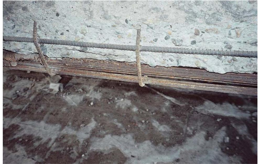
鋼材の腐食状態
