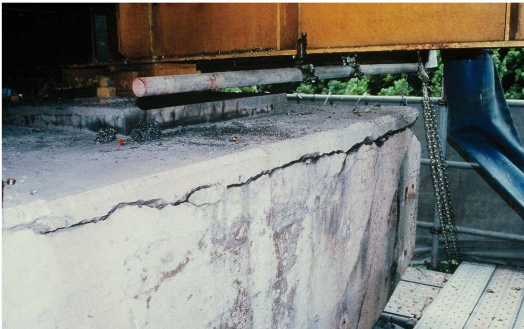
橋脚側面のひび割れ(枕梁)
