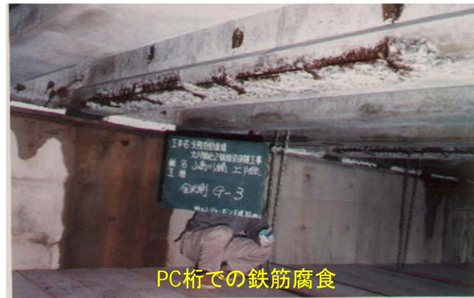
PC桁での鉄筋腐食
