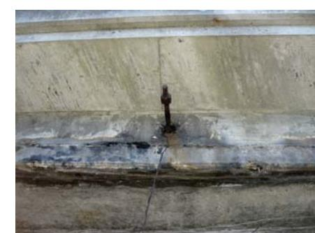
ASR膨張力 + 腐食PC鋼棒により
