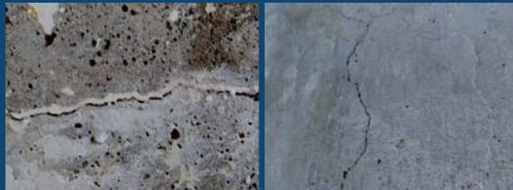
ひび割れ注入材の損傷状況
