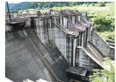
・ダム本体は、発熱量を低減するため、最大粗骨材寸法を大きくし、単位セメント量を少なくしているため、ASRが発生しにくいようである。
