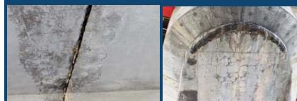
ケイ酸ナトリウム系表面含浸材塗布後の損傷状況
