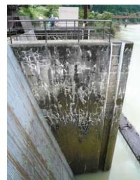
・ピア上部でASRによるひび割れが発生している。ASRの進展は、下方からの水分供給と日射による影響が関係していると考えられる。ひび割れは、白色生成物で充填されている。
