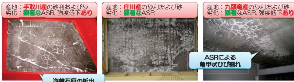
RC床版上面の劣化状況 → 補装面のひび割れ、土砂化、上面鉄筋の腐食
