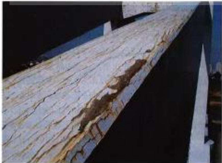
写真-1 ひび割れ発生状況
