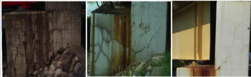
ASR劣化を生じた下部構造の補修方法の検討
