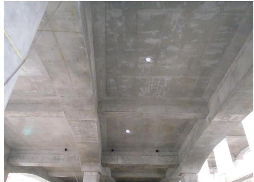
背景：上越新幹線のASR劣化(阿賀野川産骨材のASR対策)
