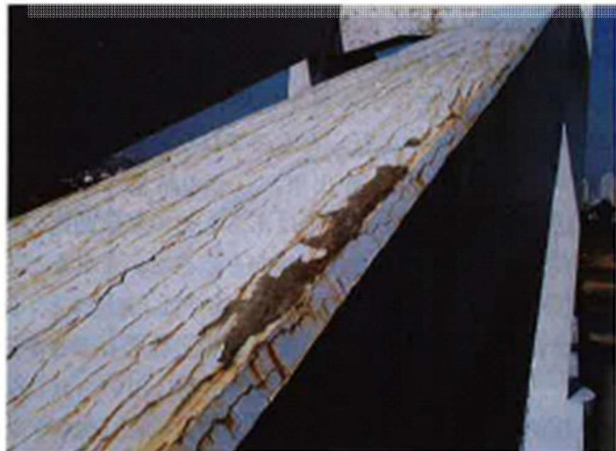
写真-1 ひび割れ発生状況
